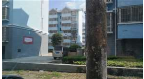
东侧170m 柳泥小区
